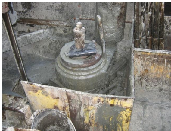
Рисунок 3 – Трубозащитное устройство во время эксплуатации в зимнее время
