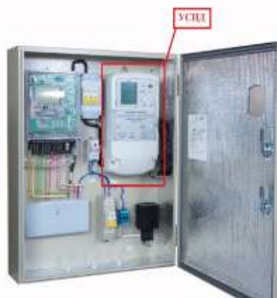
Рисунок 2. – Устройство сбора и передачи данных
